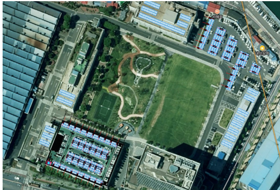
* 인천공장 태양광 발전 배치 예정 위치
